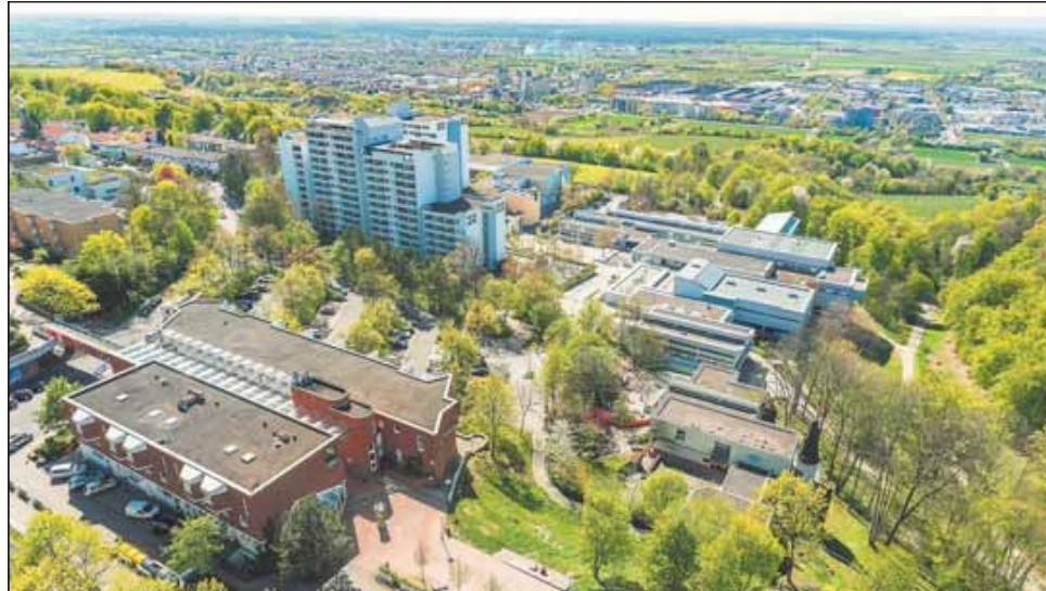
Das Gebäude vorne rechts muss abgerissen werden. Nun darf die Evangelische Kirche dort weiter planen. Foto: Christian Buck
