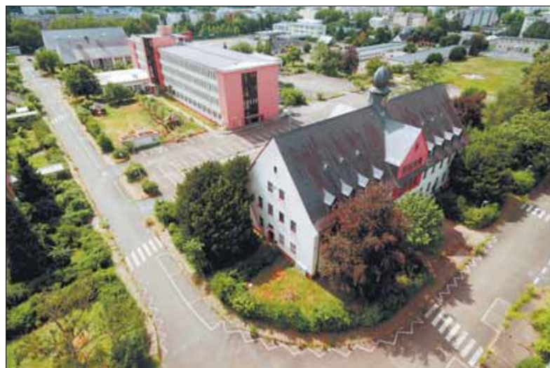
Für das Collegium-Academicum-Projekt soll das Bestandsgebäude im Vordergrund genutzt werden. Das alte Hospital-Gebäude aus den 1950er-Jahren gegenüber wird durch einen Neubau ersetzt. Foto: Christian Buck
