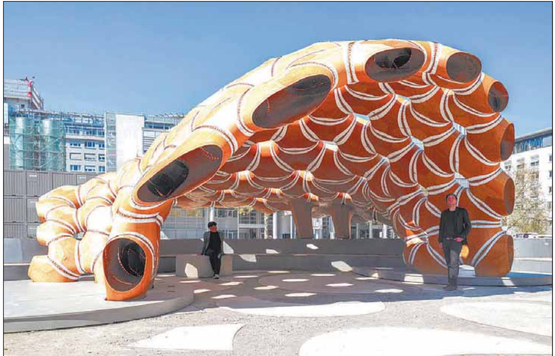
Bei diesem Forschungspavillon, gebaut am Institut für Computerbasiertes Entwerfen (ICD) und am Institut für Tragkonstruktionen und Konstruktives Entwerfen (ITKE) der Universität Stuttgart, wurden erstmals industrielle Nähtechniken für Holzkonstruktionen eingesetzt. Foto: ICD und ITKE Stuttgart
