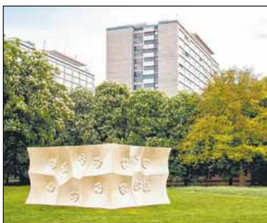
Bei „Hygroskin“ reagiert das Holz auf die Feuchtigkeit in der Luft, so öffnet und schließt sich die Gebäudehülle. Foto: Menges
