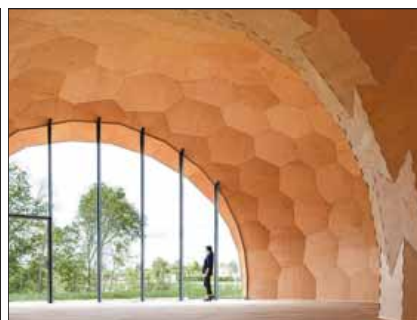
Dieser Forstpavillon wurde als Holzleichtbaukonstruktion für die Landesgartenschau 2014 in Schwäbisch Gmünd gefertigt. F.: ICD und ITKE
