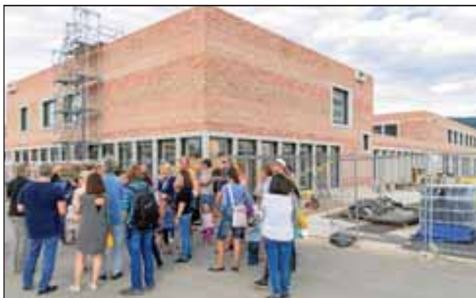
Über 30 Bahnstädter waren neugierig auf den Komplex mit Bürgerzentrum, Café, Schule und Kita. Foto: Philipp Rothe
